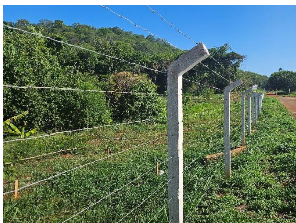
Cerca instalada Autoria: Carolina Rodrigues Bordignon Data: 28/11/2023
