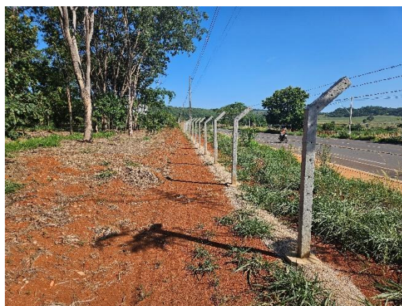
Cerca instalada Autoria: Carolina Rodrigues Bordignon Data: 28/11/2023
